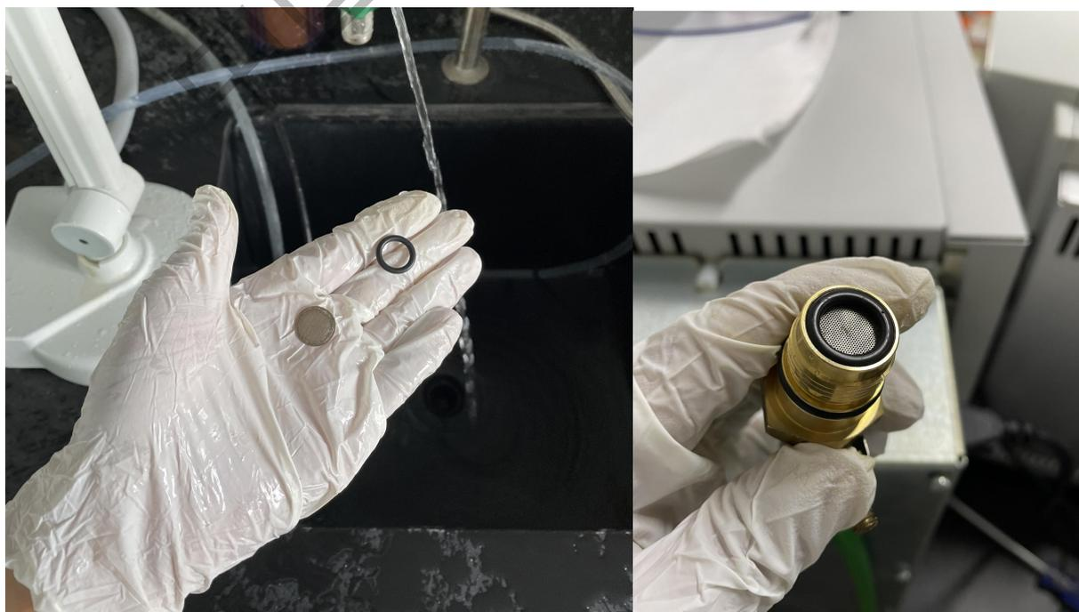
图 7 清洗滤网，重新安装
