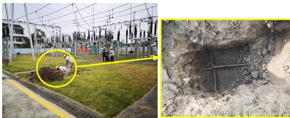
图8 第二代样机在浙江3个变电站应用并现场开挖验证
