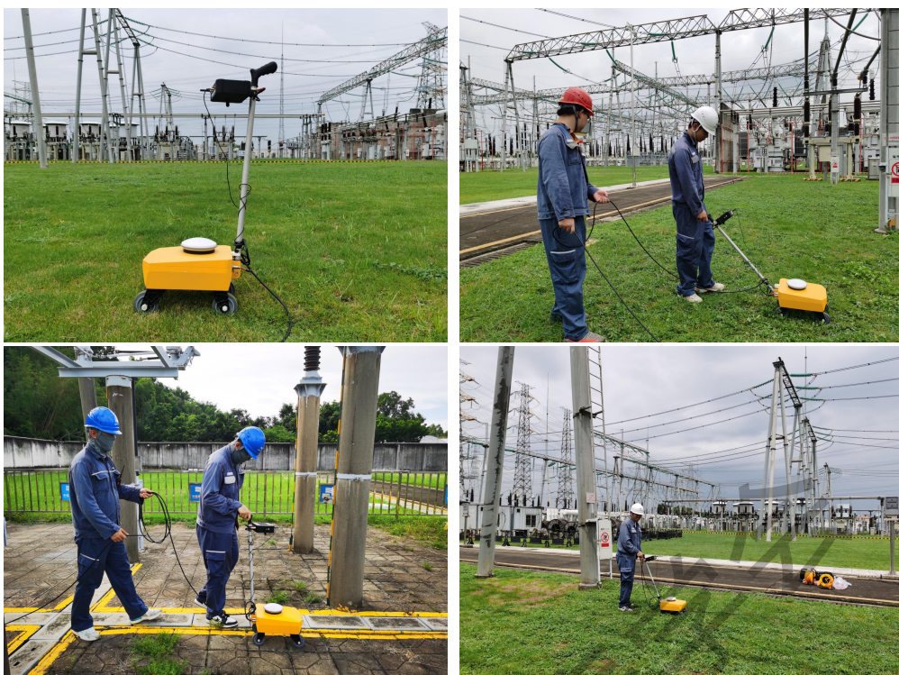
图 9 第三代样机在广东 3 个变电站应用
