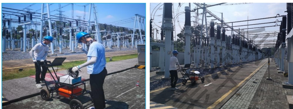
图6 第一代样机在湖北某变电站试运行
