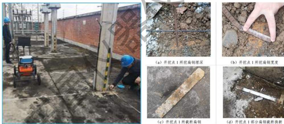
图7 第一代样机在陕西三个变电站应用并现场开挖验证
